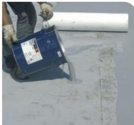
d'affectation des primaires. N'appliquer le KEMPEROL® V 210 que par température supérieure à + 5 °C – températures ambiante et du support. Par température inférieure à + 10 °C, ajouter l'activateur KEMPEROL® dans le composant B et par température supérieure à + 25 °C, l'agent inhibiteur C3.
