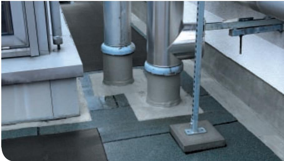
Ce système d'étanchéité a été formulé sur base d'un polymère silanisé. Au bout de 60 minutes seulement, il résiste à la pluie. KEMPEROL® 1K-SF convient aussi bien au traitement des points singuliers que pour l'étanchéité de surfaces plus importantes telles que des toitures plates ou des balcons. Les avantages économiques de KEMPEROL® 1K-SF apparaissent surtout dans le cas de petites surfaces où la simplicité de l'application joue un rôle déterminant.
